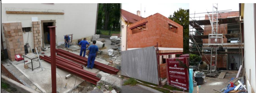
REKONSTRUKCE ŠKOLY ZAPOČALA 15 ČERVNA. A TERMÍN DOKONČENÍ 15. ŘÍJNA 2011
