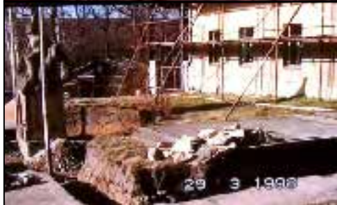
DOLE OPRAVA PŘEDZAHRADKY ŠKOLY
