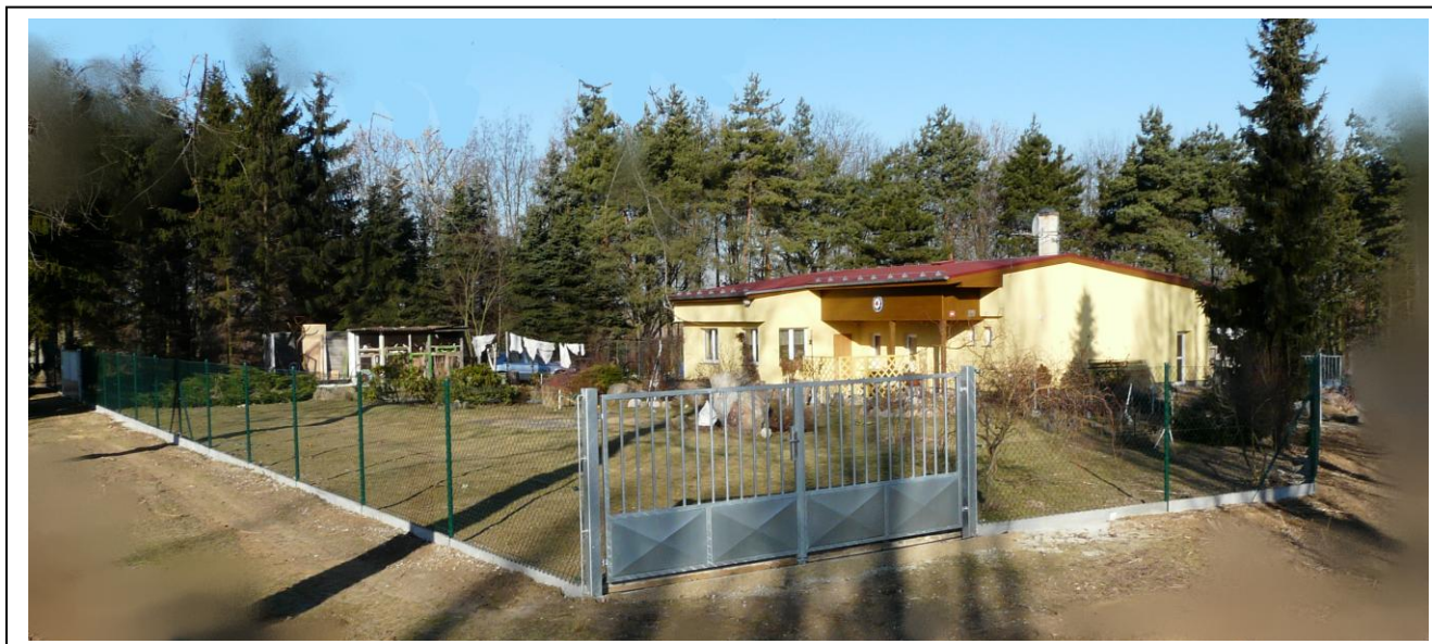
NOVĚ OPLOČENÝ AREÁL S REKONSTRUOVANÝM OBJEKTEM KABIN A BYTEM SPRÁVCE TJ SOKOL KNĚŽEVES
