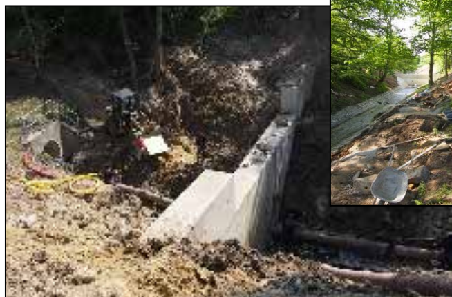
Úprava vodoteče při hlavní silnici – obr. vpravo. Vytvoření nových hrází na toku potoka v Bílé skále, které slouží k regulaci vod odvádějících se z čističky a prostor letiště – obr. vlevo. foto R.
