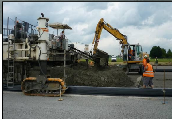
POKLÁDKA VRCHNÍ BETONOVÉ DESKY FINIŠEREM
